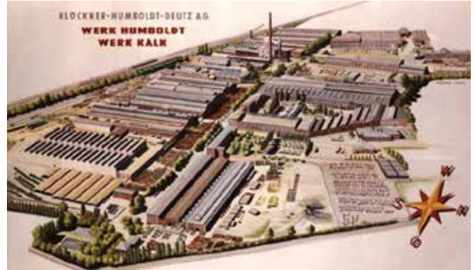
Werksgeleände Klöckner-Humboldt-Deutz AG. Werk Humboldt / Werk Kalk. Illustration, 1960.
